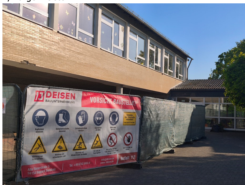
Bauarbeiten an der Grundschule Dieblich
